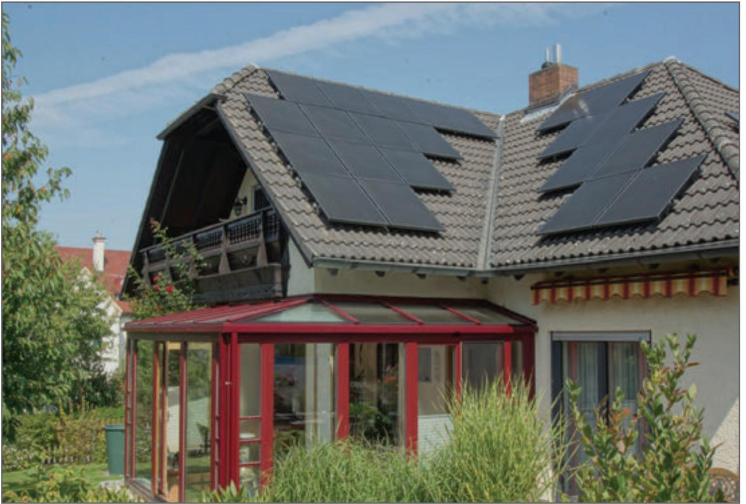
Der Anbau beginnt unter dem Balkon und wird um die Ecke bis zur Hauswand geführt. Der kleine Glasdach-Vorsprung von nur 1m realisiert großzügigen neuen Wohnraum. Dark Red Meranti außen deckend weinrot, innen farblos endbehandelt.
