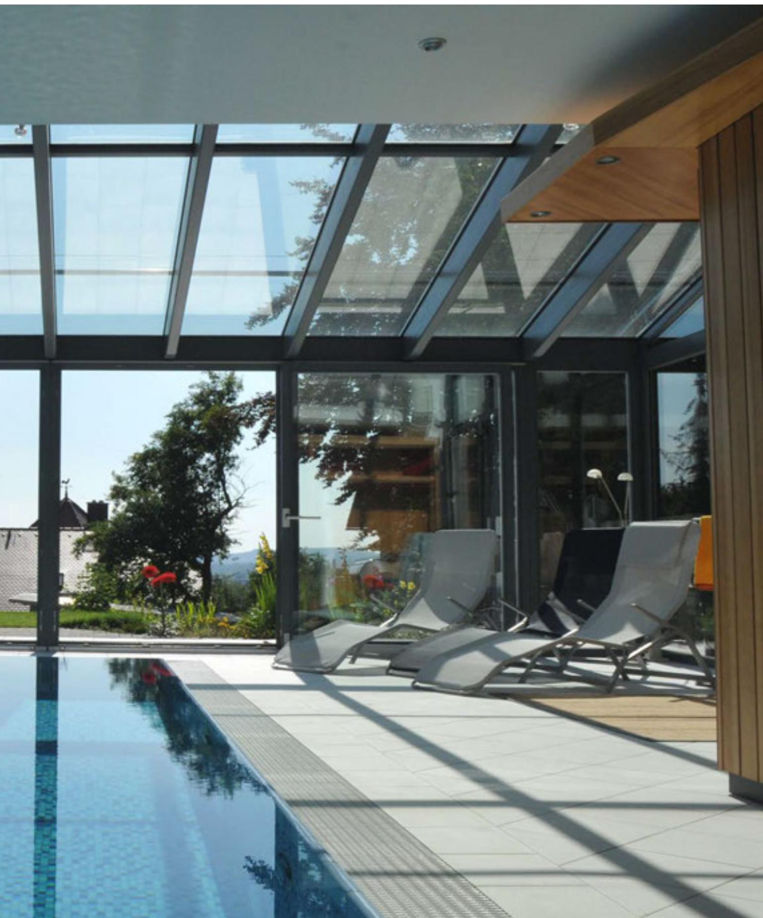
Ausführung in hoch feuchteresistentem Dark Red Meranti, innen und außen deckend blaugrau. Die warme Holzoberfläche vermeidet Kondensat.
