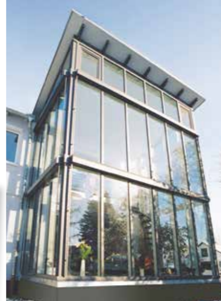
Pfosten-Riegel-Fassade; Innen: Dark Red Meranti deckend lichtgrau Außen: pulverbeschichtetes Aluminium
